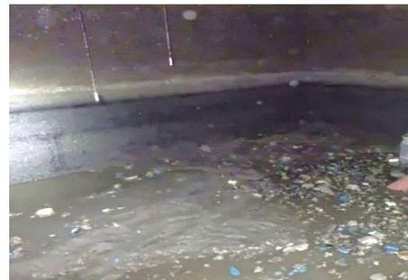
解体工事による無断排水があり、下水道管やポンプ場にコンクリートガラやノロが流入している状況。
