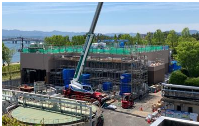
【新1系水処理施設建設工事（現況）】
