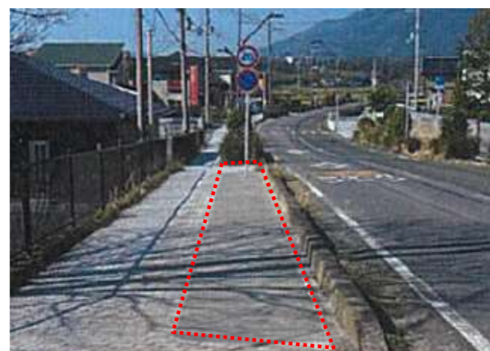
街路樹帯の撤去による歩道拡幅
