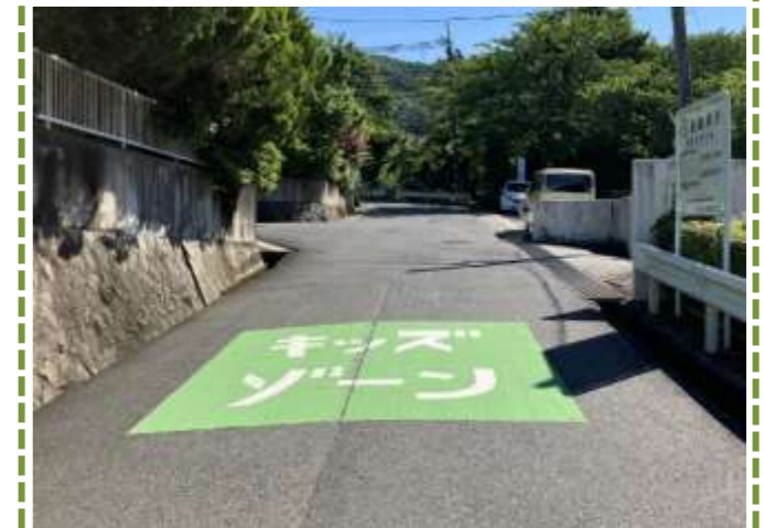
⑤外側線がない
