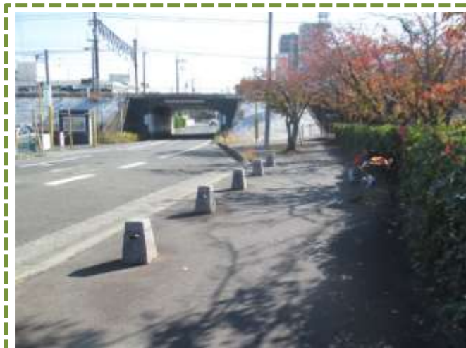
①視覚障害者誘導用ブロックの設置なし
