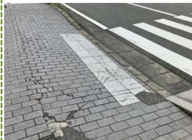
③視覚障害者誘導用ブロックの破損、視認性が悪い
