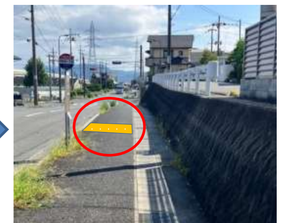
(写真-1 バス停までの誘導例(案):視覚障害者誘導ブロック(点状)を横断的に設置)
