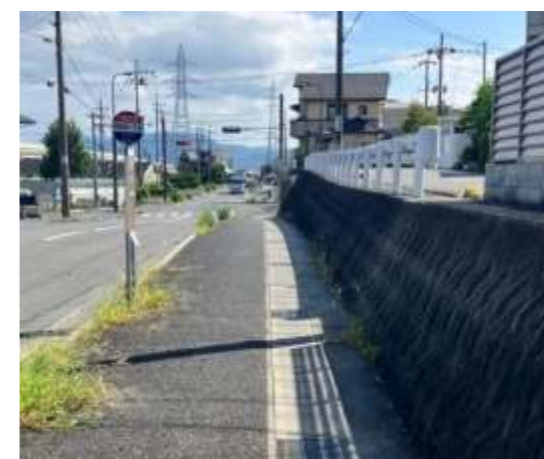
(写真-1 バス停までの誘導例(案):視覚障害者誘導ブロック(点状)を横断的に設置)
