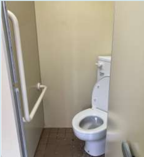
トイレ改修(伊香立公園)
