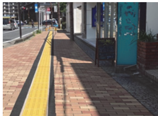
輝度比を確保した点字シートの設置例
