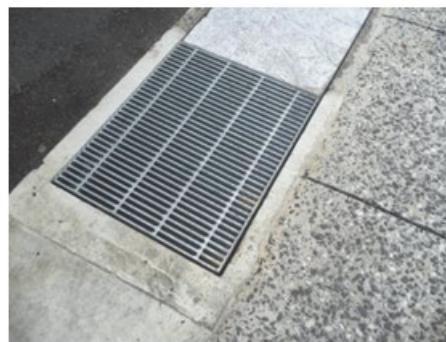
グレーチングの改良
