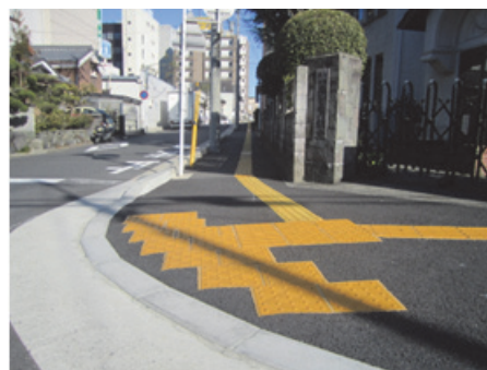
点字ブロックの整備
