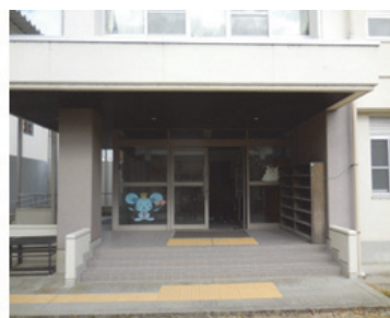
点字ブロックの設置
