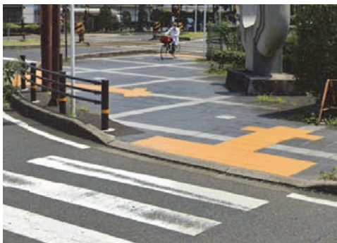
交差点部における点字シートの設置例
