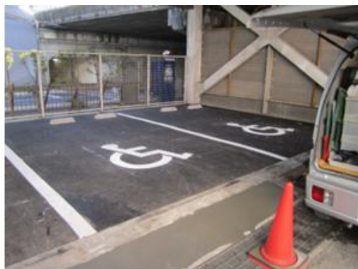
車椅子使用者用専用駐車場の整備
