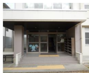
点字ブロックの設置
