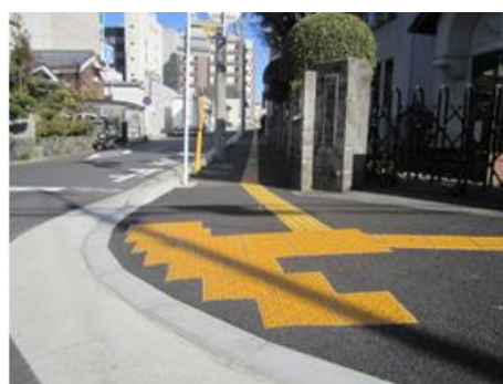
点字ブロックの整備
