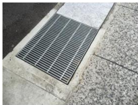
グレーチングの改良
