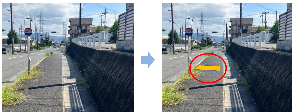
(写真-1 バス停までの誘導例(案):視覚障害者誘導用ブロック(点状)を横断的に設置)
