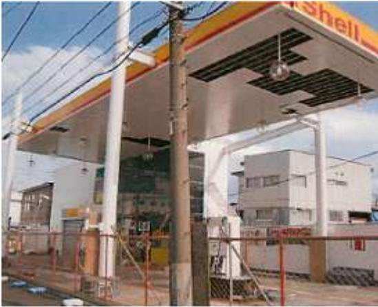
地震により建築物の屋根のパネルが落下している。
