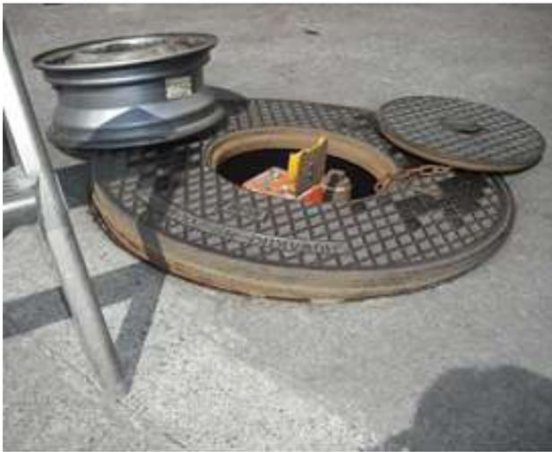
地震により、マンホール周囲のコンクリートが変形し、マンホールが浮き上がっている。
