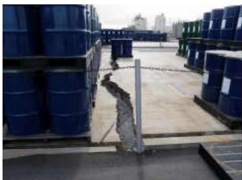
地震により屋外貯蔵所の床面がひび割れている。
