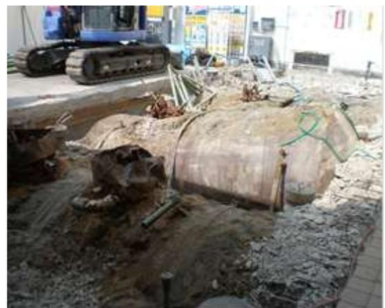
液状化により地下貯蔵タンクが浮き上がっている。写真は、タンクを撤去するため上部スラブ等を撤去している。
