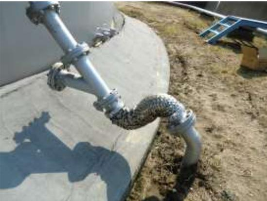
液状化により屋外貯蔵タンクの可とう管が変形している。
