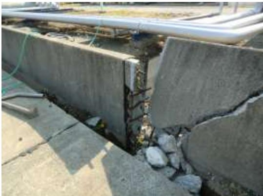
液状化により、防油堤が沈降し目地部分が裂けている。
