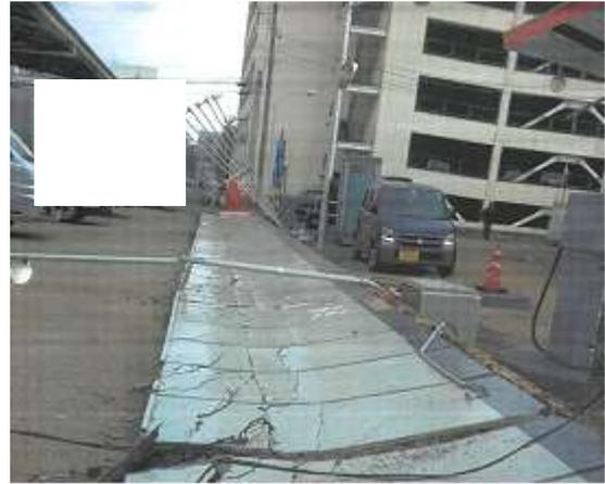
地震により防火塀が倒壊している。
