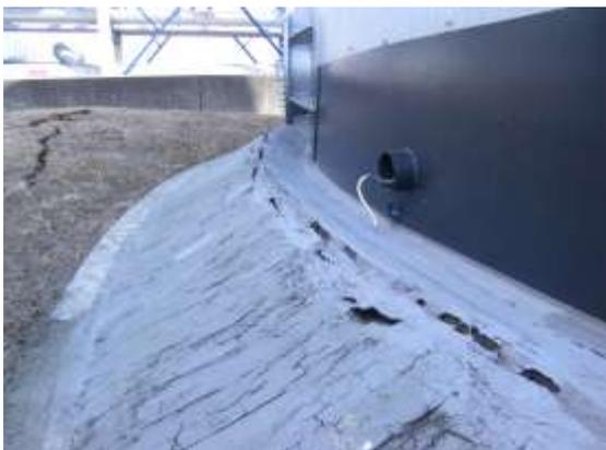
液状化により屋外貯蔵タンクが沈下し犬走りにひび割れが生じている。
