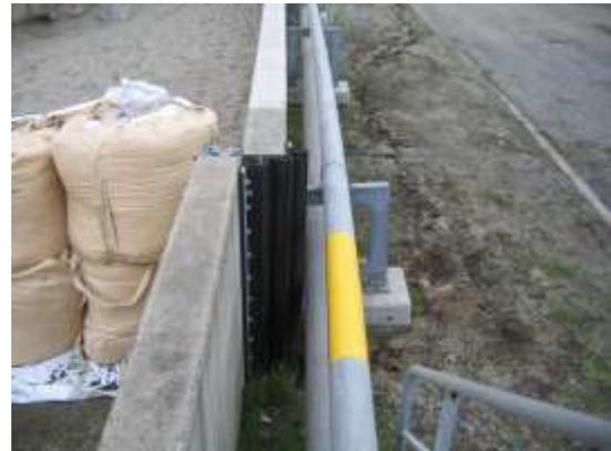
液状化により、防油堤の目地部分がずれている。
