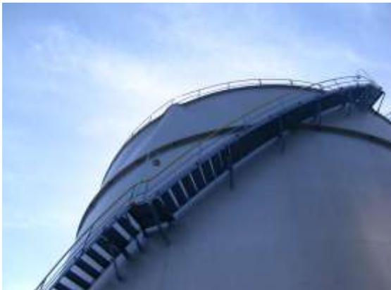
地震により、屋外貯蔵タンクの側板頂部が開口している。
