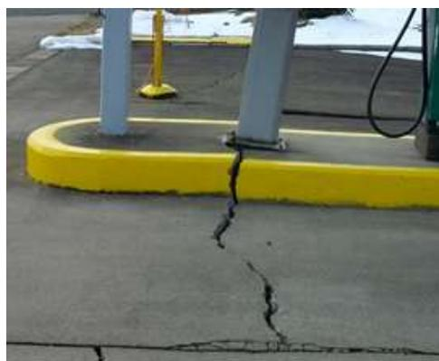
地震により地盤面に段差が生じている。地震によりアイランド付近に亀裂が生じている。
