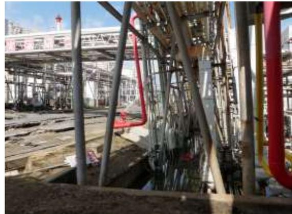
液状化及び地盤移動により配管ラックが傾斜している。
