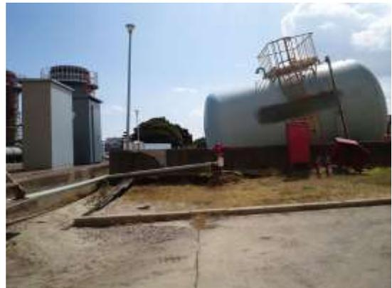
液状化により、屋外貯蔵タンクが傾斜している。
