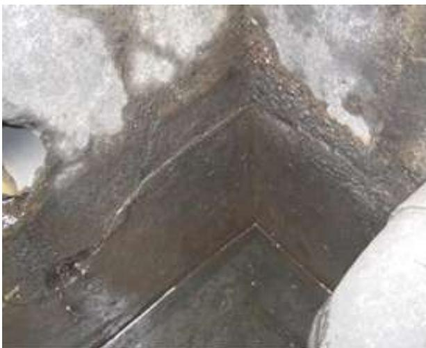
地震により、油分離槽内部に亀裂が生じ、装置内部の水が流出している。
