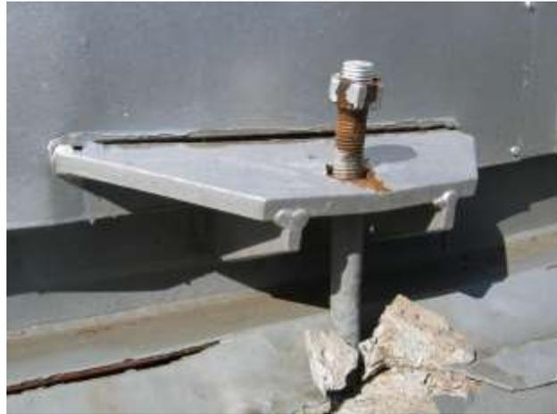
地震によりアンカーボルトが破断、引き抜かれている。
