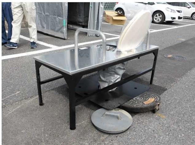
次に、マンホール部分に鉄板を置いた後に、トイレ本体を上部に搬送します。
