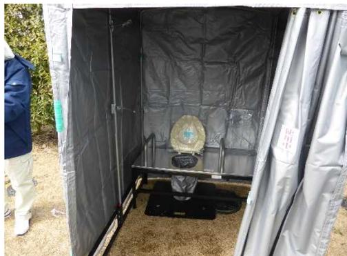
テント部分をマンホール部分に移動させれば、マンホールトイレの完成です。
