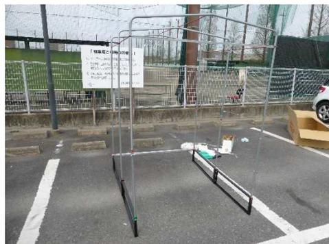
次に、補強用のバーと前部分のカーテンレールを乗せてから、天井部分の部品を差し込みます。
