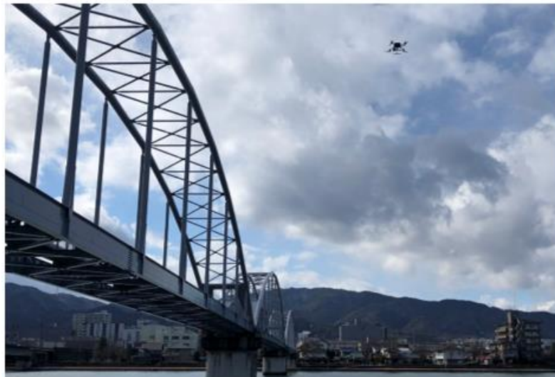
【瀬田川共同橋のドローン点検の様子】
