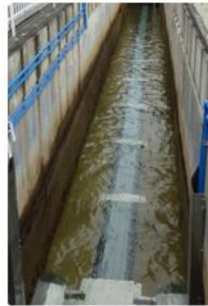
【消毒槽への熱回収管敷設状況】
