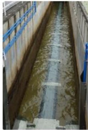
【消毒槽への熱回収管敷設状況】
