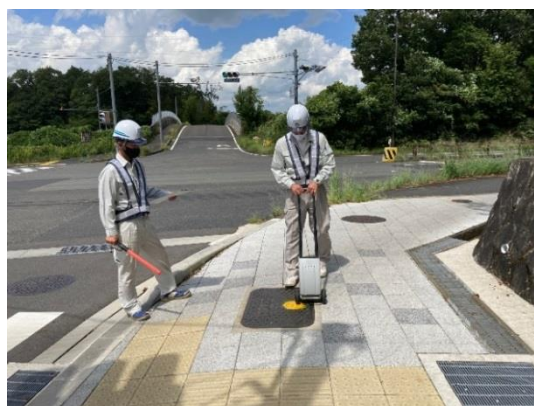
【ガス導管漏えい検査の様子】
