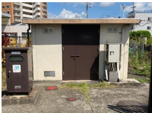
【鉄筋コンクリート造】
