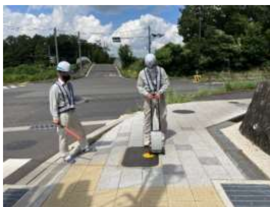
【ガス導管漏えい検査の様子】
