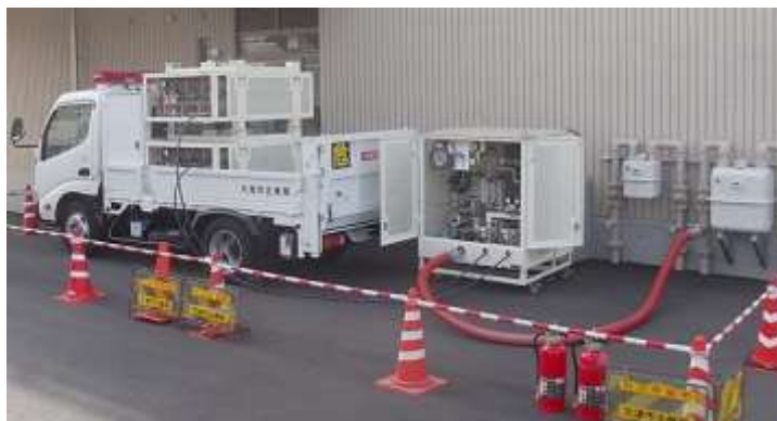
【移動式ガス発生設備によるガス供給状況】
