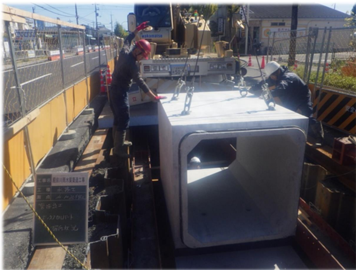
【殿田川雨水渠築造工事】
