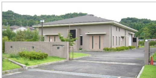
【大石中継ポンプ場】
