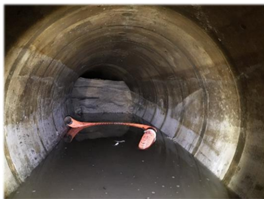
【土砂による閉塞】
