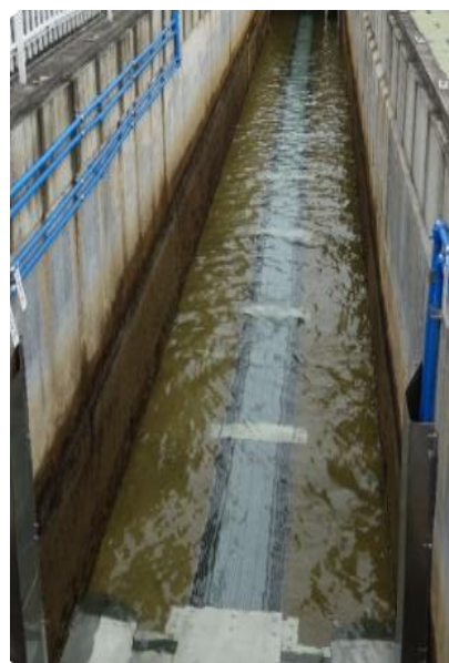
【消毒槽への熱回収管敷設状況】
