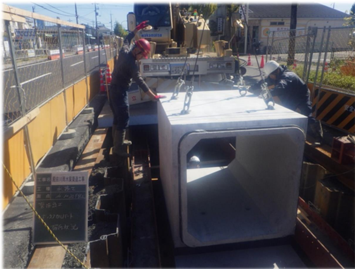
【殿田川雨水渠築造工事】
