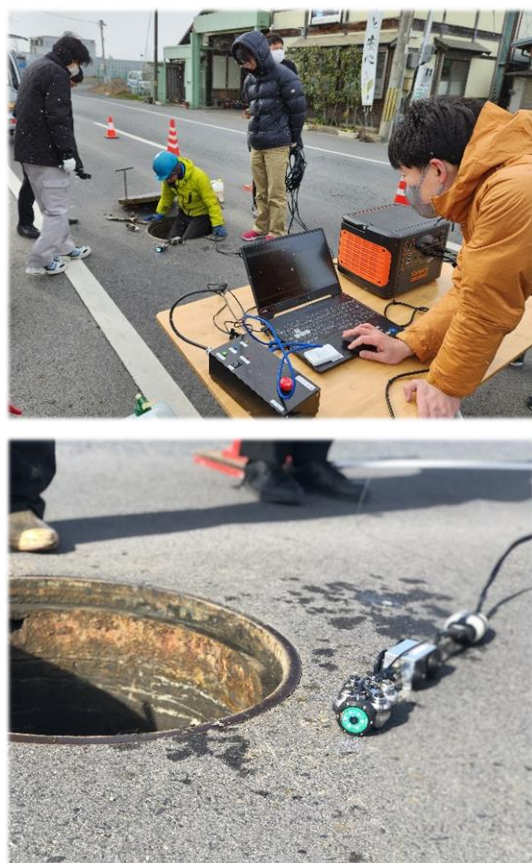
【小口径圧送管点検ロボット実証実験】
