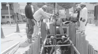
耐震管布設状況
