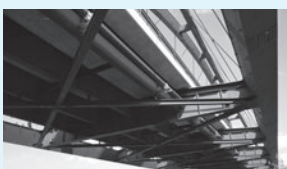
地域をまたぐ安定供給のための橋梁へのガス管設置
