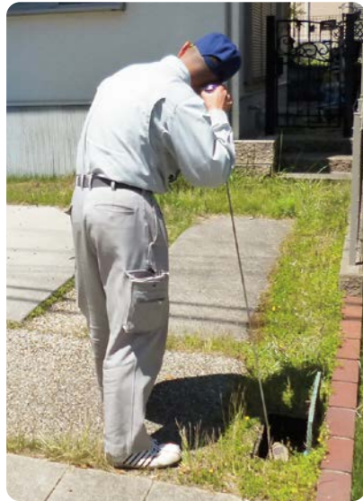
宅内の水道メーターなどに音聴棒をあて、漏水音の有無を調査します。
