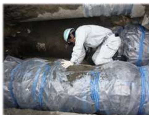
【御陵町水道管の修繕状況】
