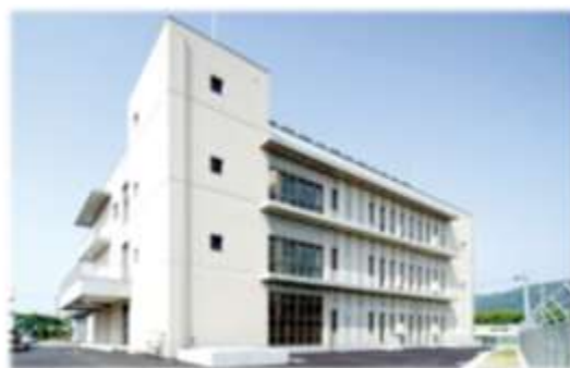
【浄水管理センター外観】
