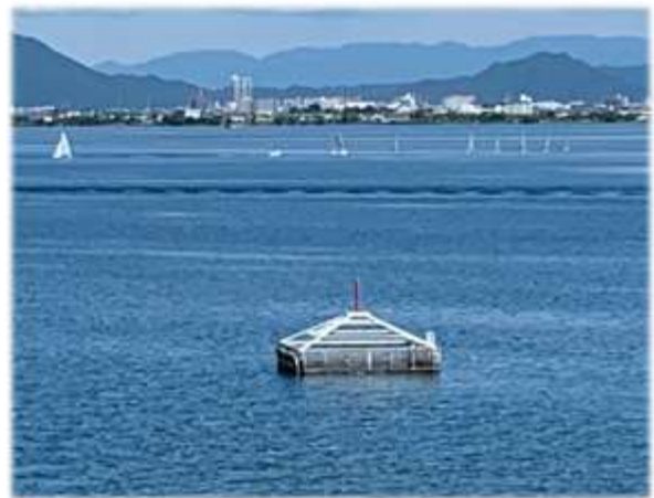
【柳が崎浄水場の取水口】
