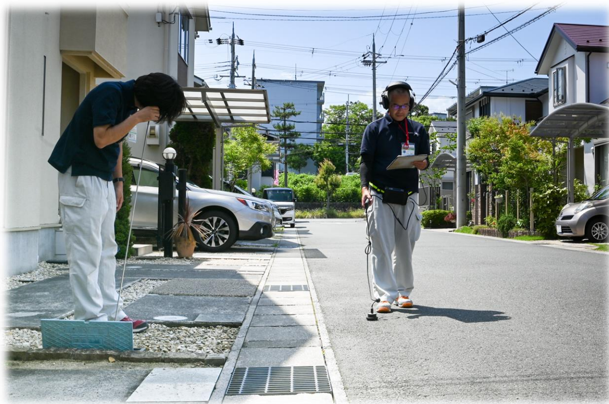
【漏水調査の様子】
