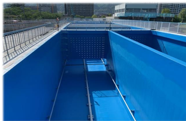
【耐震補強施工後の柳が崎浄水場沈殿池】
