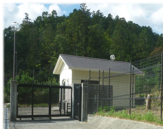
【南小松加压施設】
