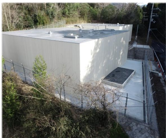
【耐震補強を行った関津配水池】
