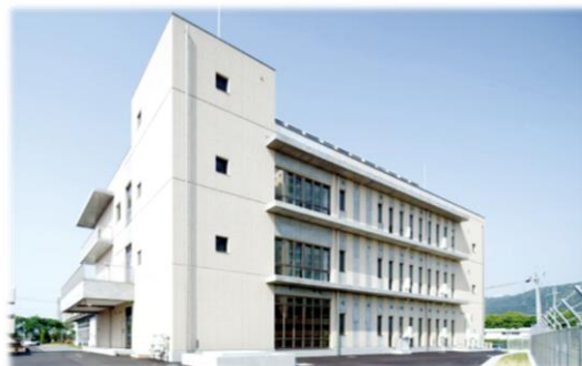
【浄水管理センター外観】
