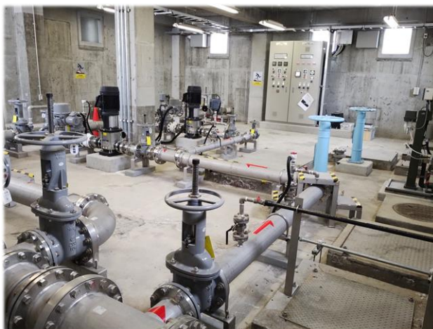
【設備更新を行った比良加圧ポンプ場】
