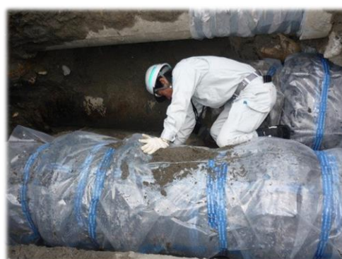
【御陵町水道管の修繕状況】
