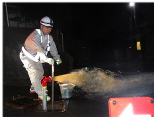
【水道管の洗浄作業（夜間作業）】
