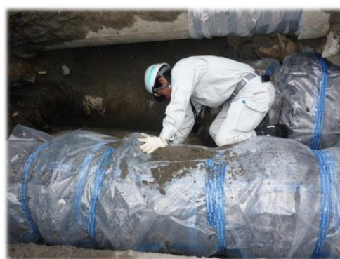
【御陵町水道管の修繕状況】
