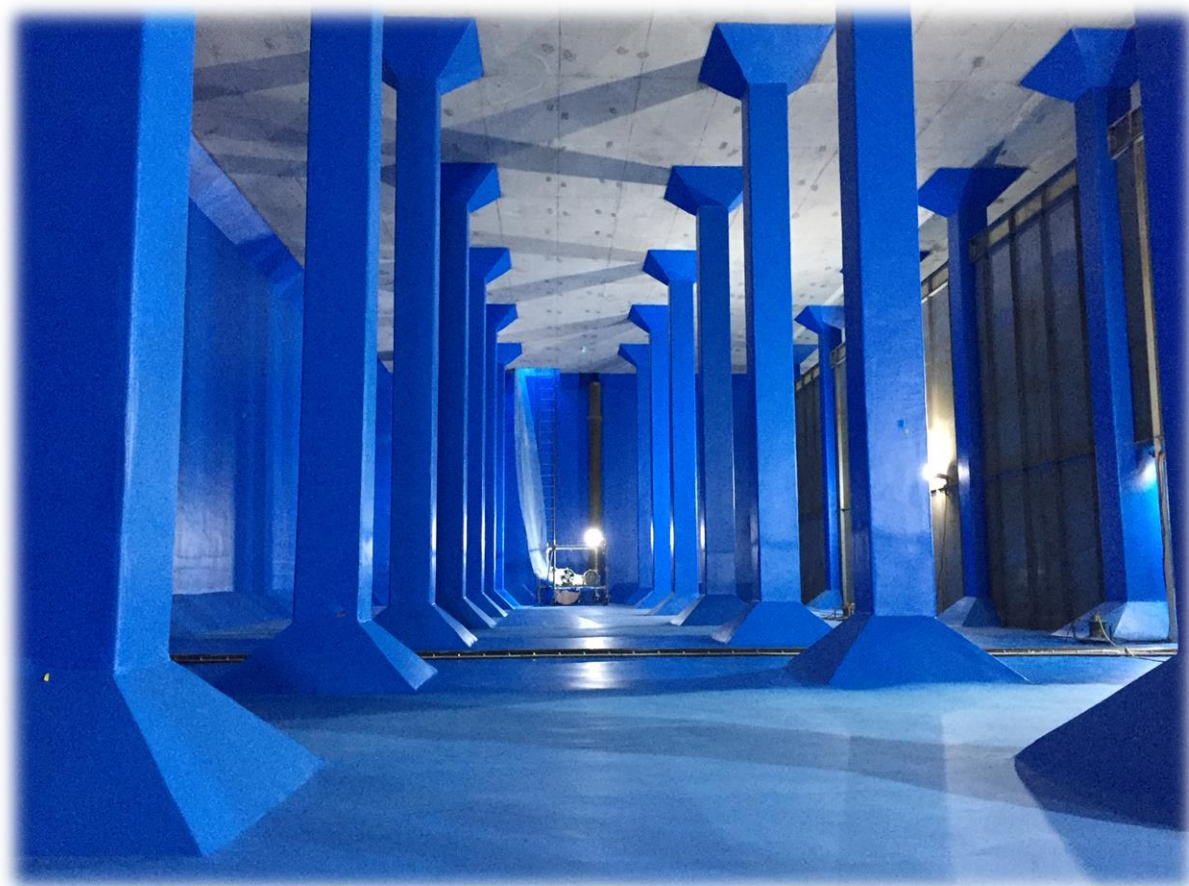
【耐震補強工事後の山上低区配水池】
