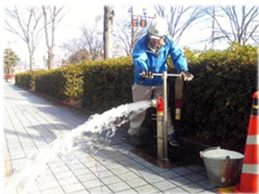
【水道管の洗浄作業（昼間作業）】
