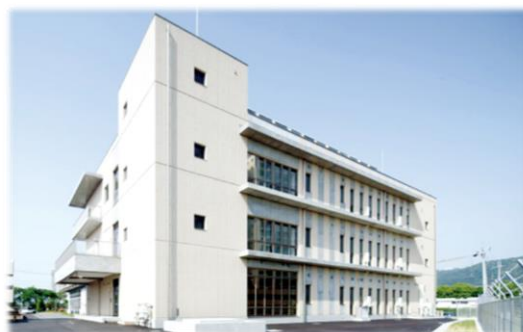
【浄水管理センター外観】
