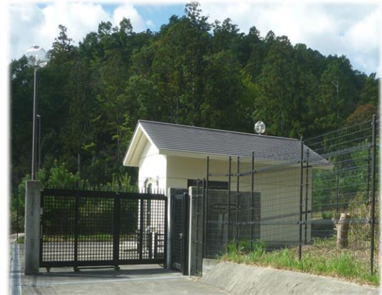
【南小松加圧施設】
