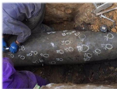
【老朽化し、管外面が腐食している水道管】
