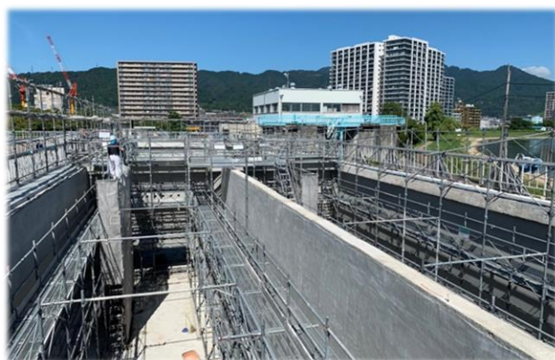
【耐震補強施工中の柳が崎浄水場沈殿池】
