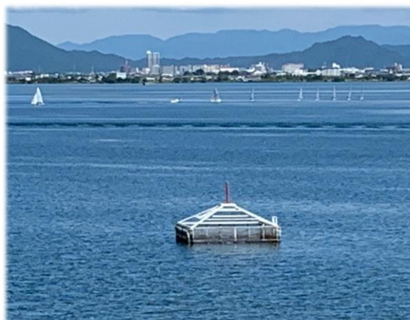
【柳が崎浄水場の取水口】
