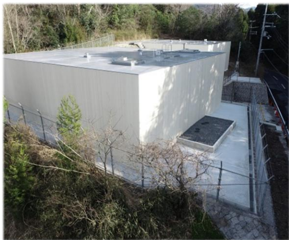
【耐震補強を行った関津配水池】
