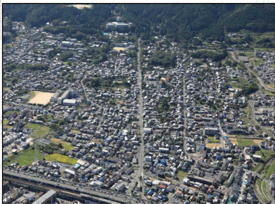
3・4・46号比叡辻日吉線の整備状況
