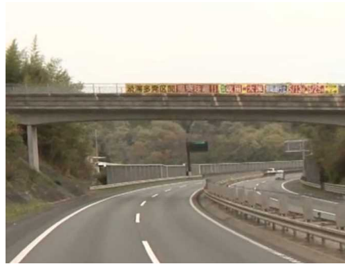
坂口橋（京滋バイパス）
