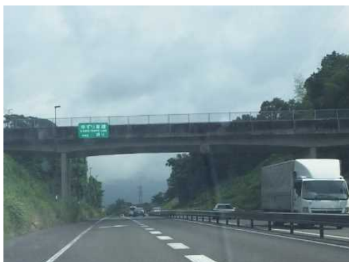
西尾橋（国道 161 号）
