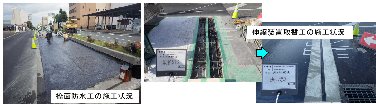
水の浸入を防ぐための工事例
