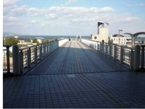
大津港連絡歩道橋
