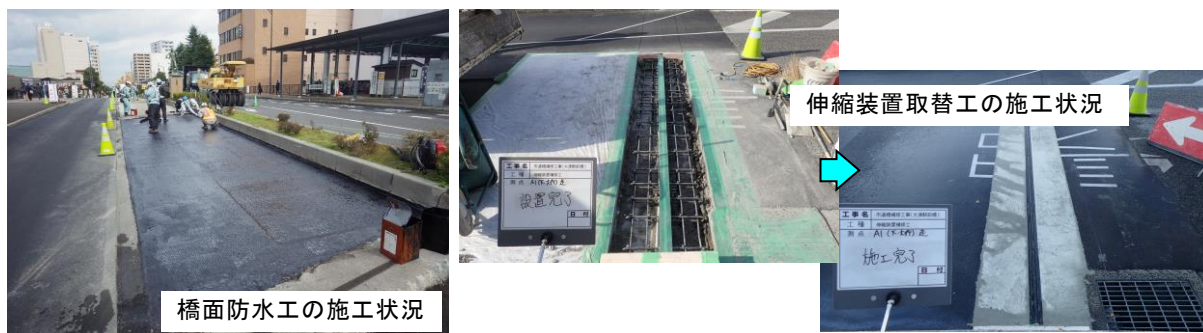
水の浸入を防ぐための工事例
