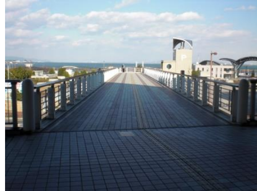
大津港連絡歩道橋
