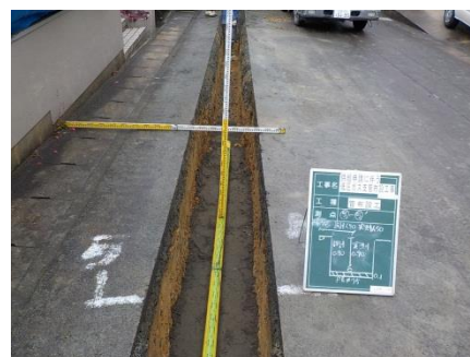
② ガスパイプの布設状況
