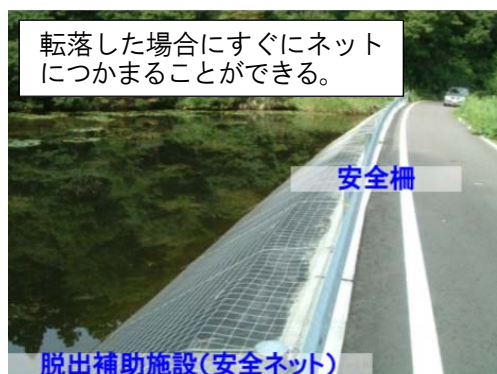
写真15：安全ネットの設置
