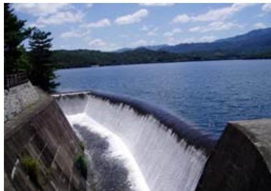
写真2：洪水吐 (香川県HPより)
