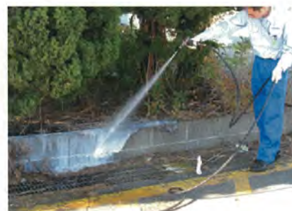
専門業者による液剤の高圧散布
