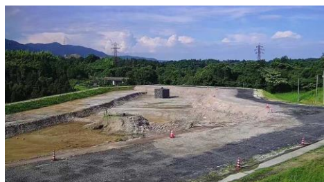
一般廃棄物最終処分場
