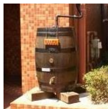
雨水貯留タンク
