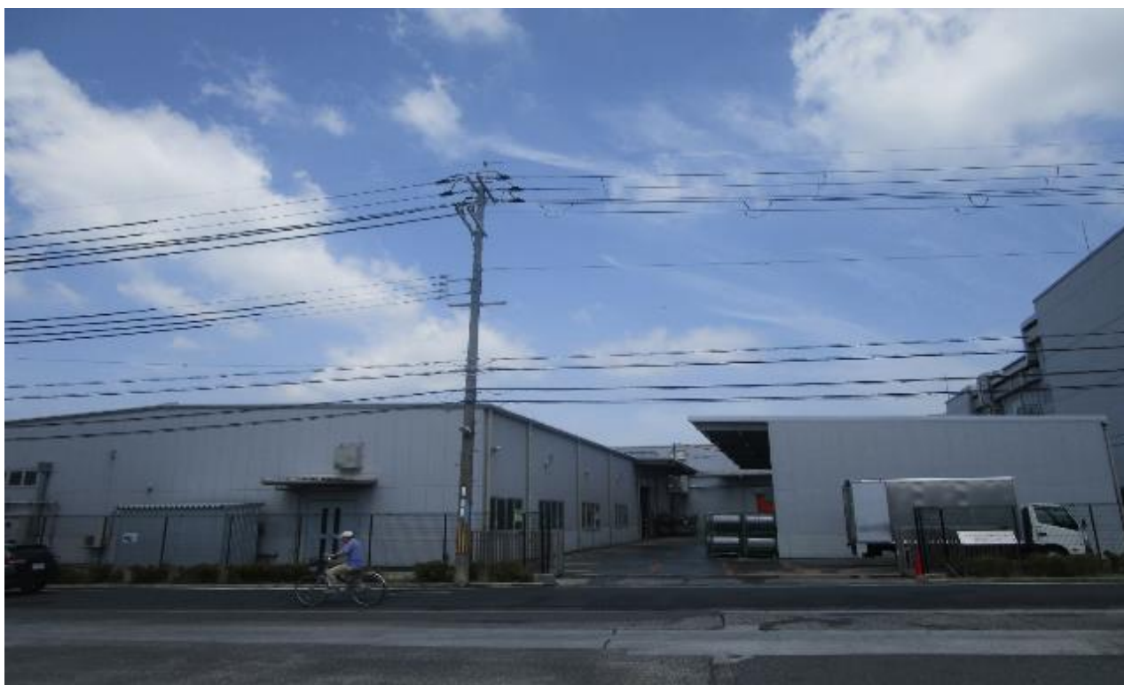
瀬田・第2工場全景
