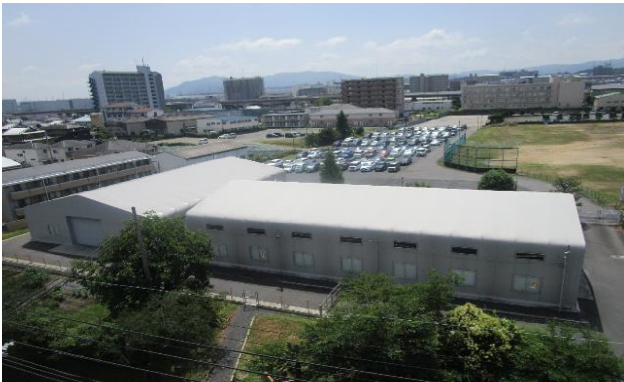
瀬田工場 新原鉱倉庫全景
