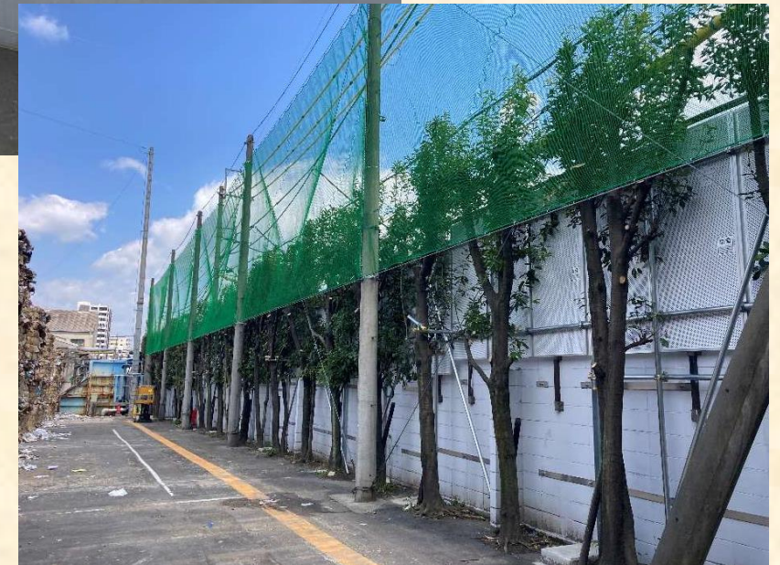
古紙ヤード東壁 飛散防止ネット設置
