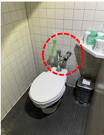
(1) 排水レバーの固定
