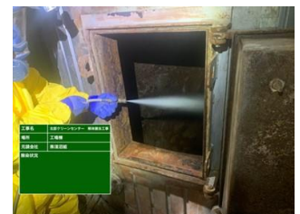
写真 2. 内部除染作業
