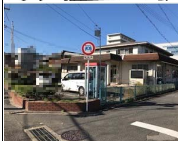
打出浜 1-5 (旧市民センター)
