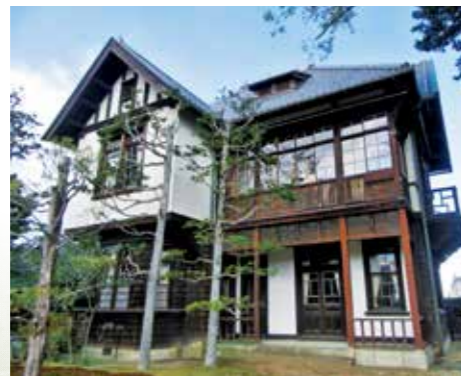
旧伊庭家住宅(住友活機園)洋館(田辺町)
