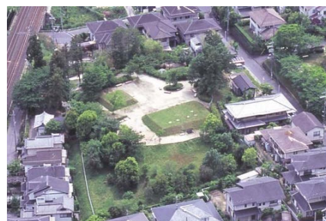
写 3-31 衣川廃寺跡の整備 (衣川二丁目)
