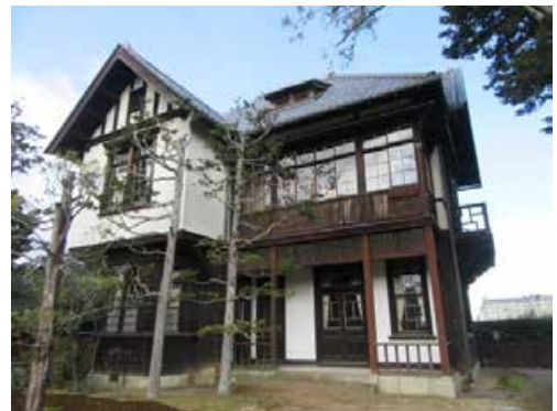
写 5-38 旧伊庭家住宅（住友活機園）洋館（田辺町）
