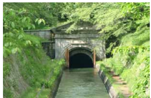
写 5-39 琵琶湖疏水・第一隧道入口
