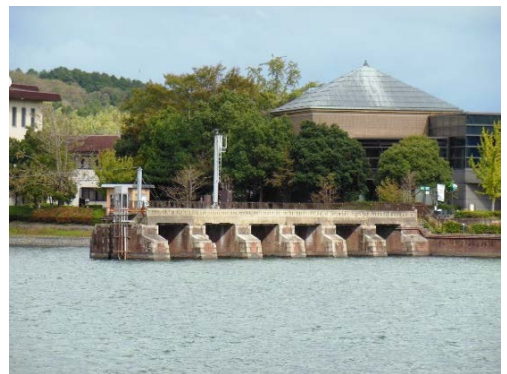
写 3-17 旧南郷洗堰の堰柱
